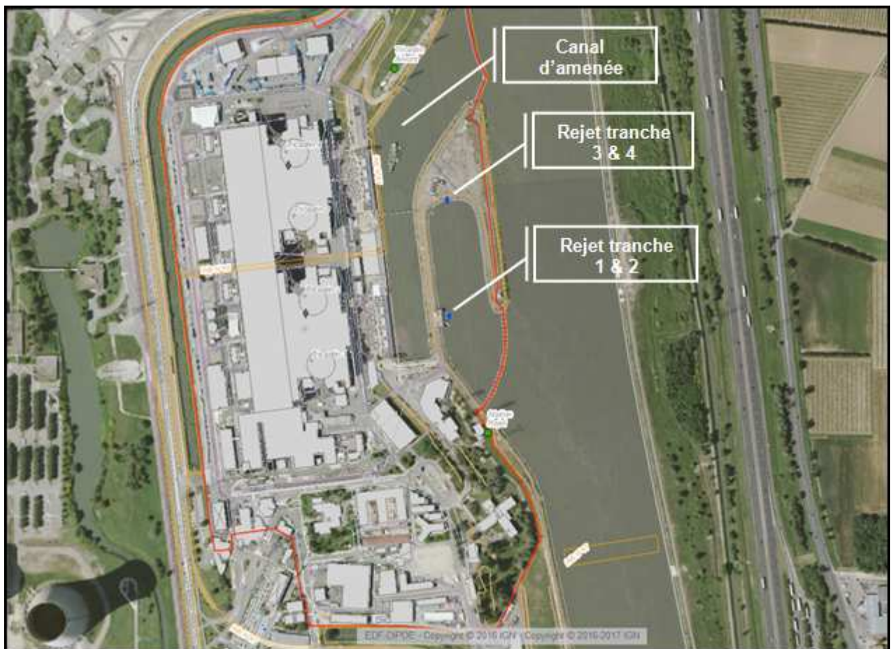
Figure 1 : Ouvrages de rejet du CNPE du Tricastin
